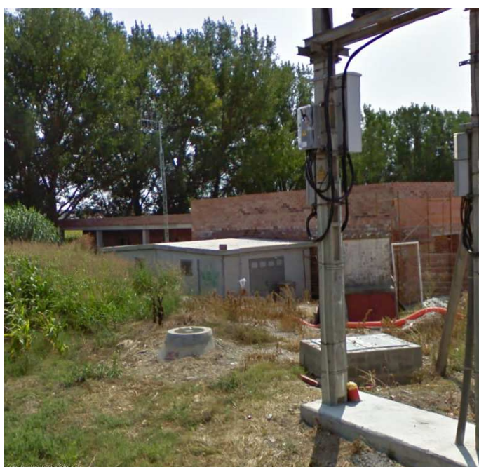
Caseta de cloració
